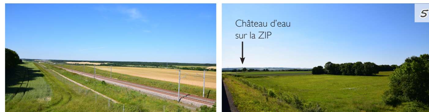
Fig. 25 : La ligne LGV à proximité de Xambes et vue en direction de la ZIP depuis le pont sur la LGV
